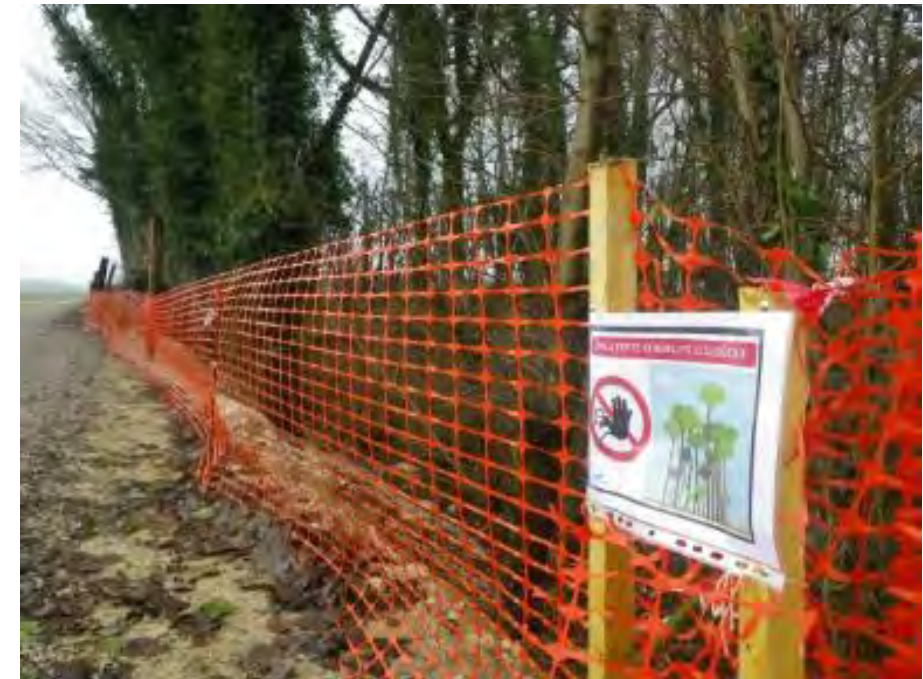
Figure 179. Exemple de balisage en phase travaux (source : BIOTOPE)
