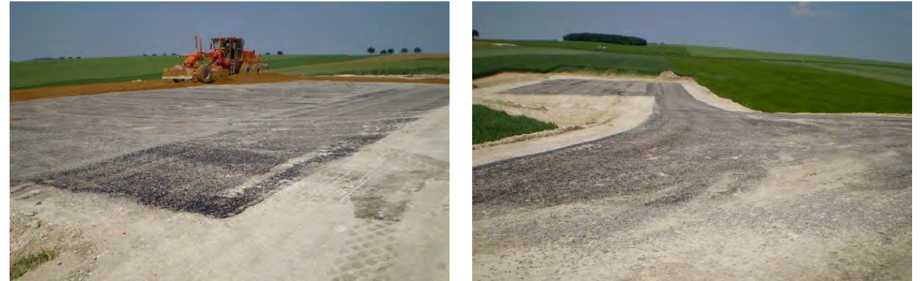
Figure 138. Aménagement des plateformes de grutage ©WPD
