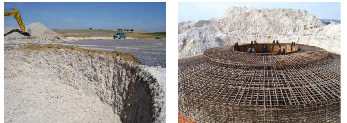
Figure 139. Construction des fondations des éoliennes ©WPD
