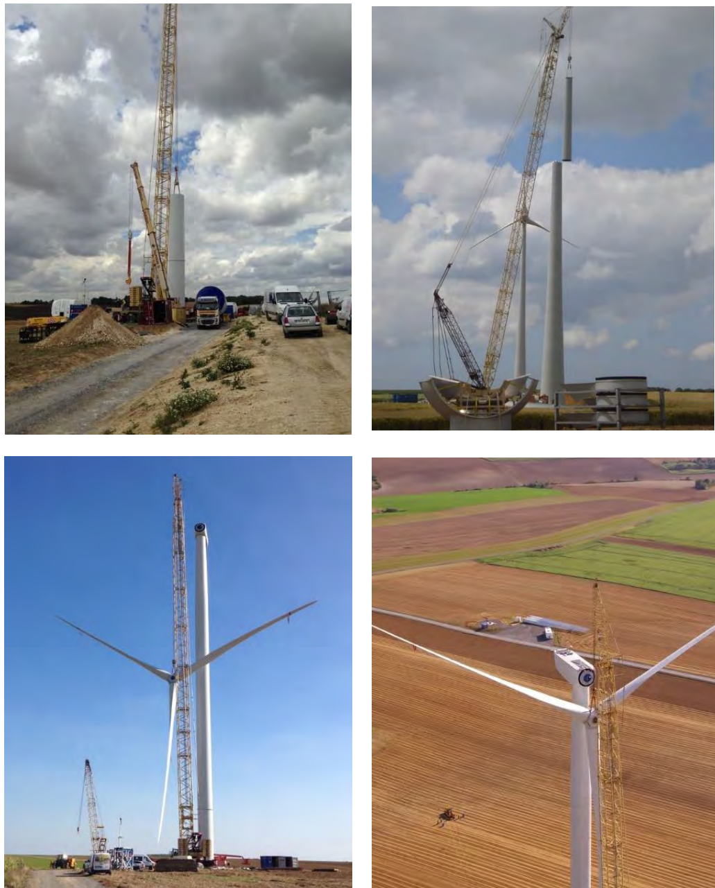
Figure 142. Montage du mât et levage du rotor ©WPD
