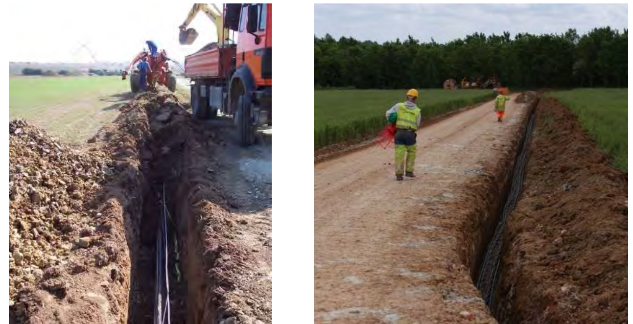
Figure 143. Travaux de raccordement électrique ©WPD
